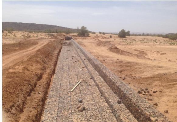
Photo n°2 : Ancrage en gabion assurant la solidité de l'ouvrage
