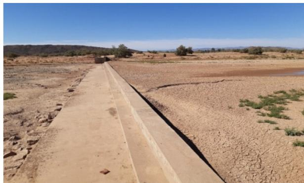
Photo n°3 : Deux mois après la crue, l'amont de l'ouvrage présente encore des traces d'eau alors qu'à son aval, le lit d'oued est tari.
