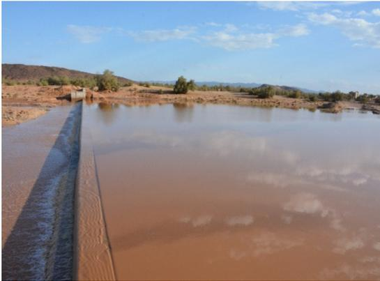
Photo n°1 : Barrage plein, vitesse de la crue ralentie, réalimentation de la nappe
